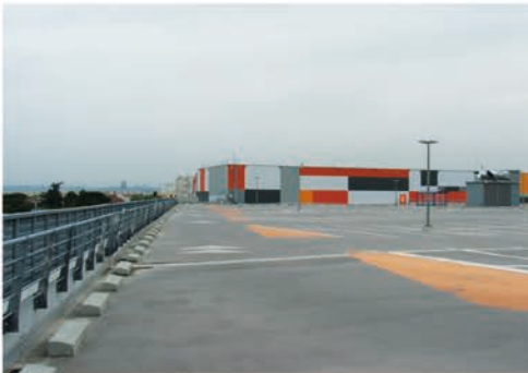
1 : Parking en toiture du bâtiment de 3 étages.
