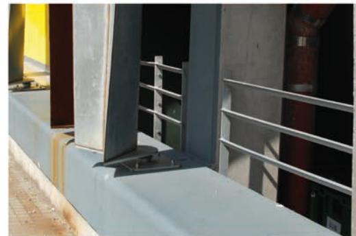
4 : Zoom sur le muret servant d'assise
