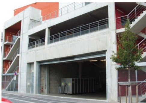
1 : Porte coulissante pour accéder aux zones logistiques
