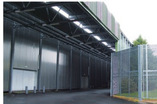
4 : Tunnel de livraison avec un espace ouvert en toiture et la butte végétale à droite.
