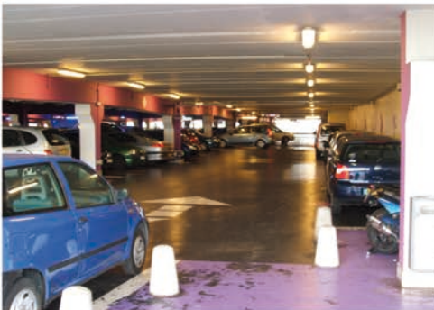
2 : Vue à l'intérieur du parking
