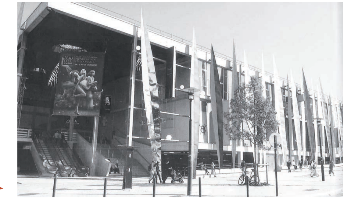
Vue sur l'entrée principale depuis le Boulevard Général de Gaulle.
