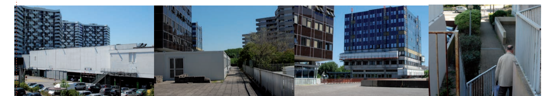
Depuis la place située en contrebas des immeubles de logements et de bureaux:
