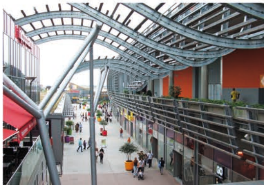
2 : Mail depuis la passerelle (Enseigne Jardineland au fond du mail)
