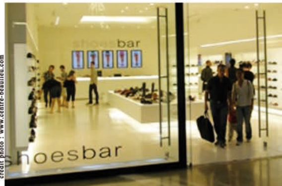
4 : Paroi totalement vitrée - présence d'un seul adhésif
