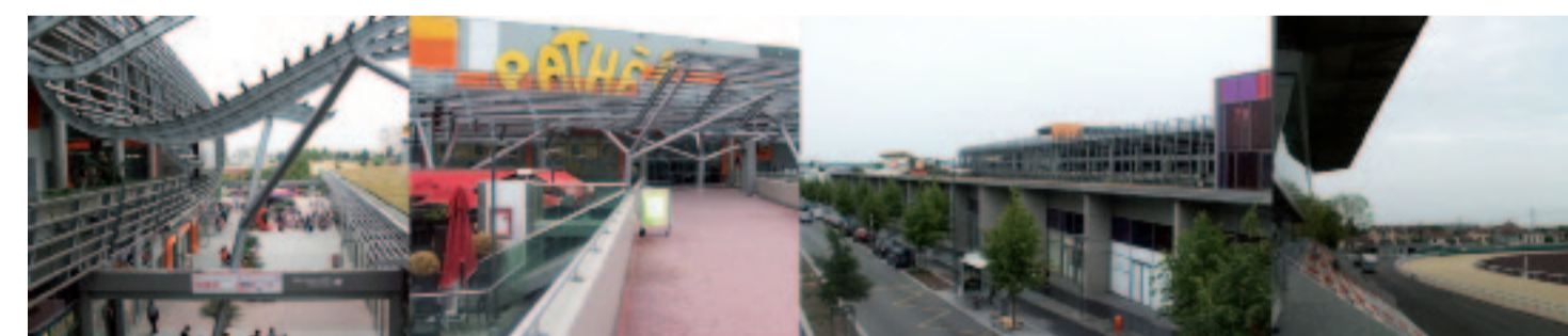
Traverser les trois parties du complexe de loisirs en empruntant la passerelle : 1 : Vue sur le mail piéton à ciel ouvert entre les deux bâtiments du complexe 2 : Vue en direction du cinéma 3 : Vue en direction de l'hippodrome et ses restaurants 4 - 5 : Aménagement à l'intérieur de l'hippodrome (tribune, skatepark, ...)
