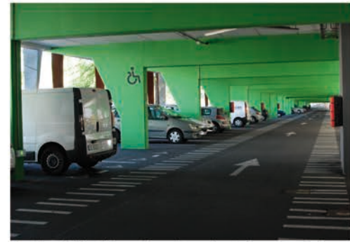
4 : Vue à l'intérieur d'un étage de stationnement dans le silo
