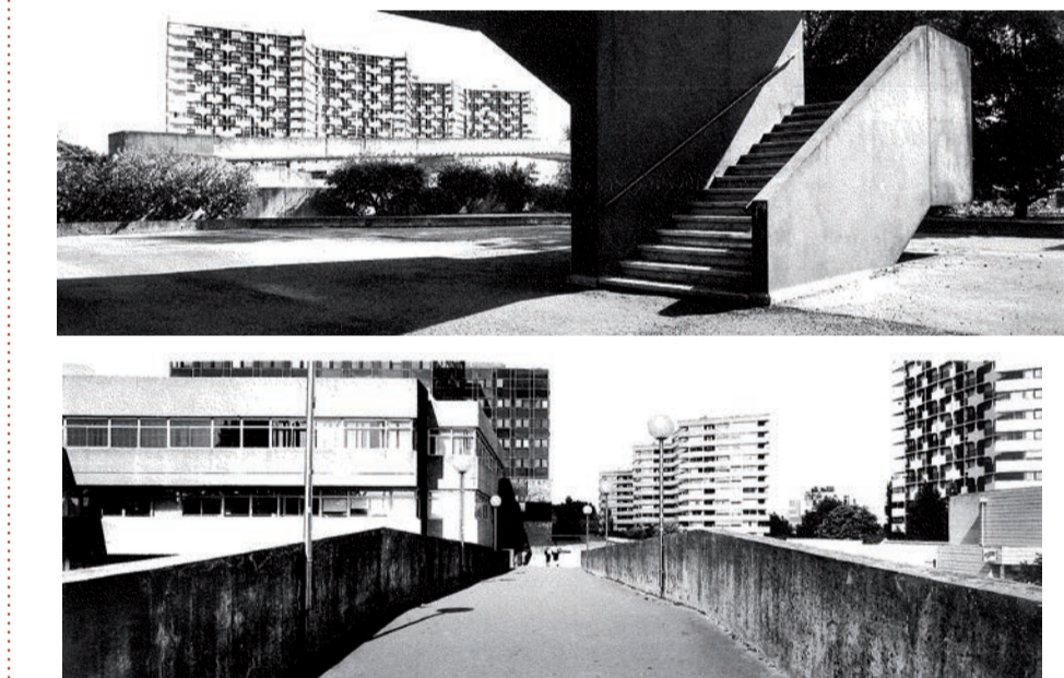
Passerelle reliant l'entrée secondaire du centre commercial Beaulieu en direction des logements.
