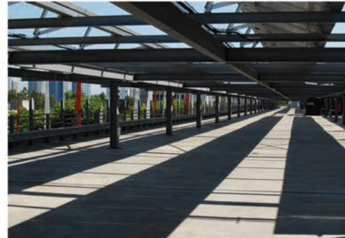
4 : Centrale photovoltaïque située sur le parking en toiture.
