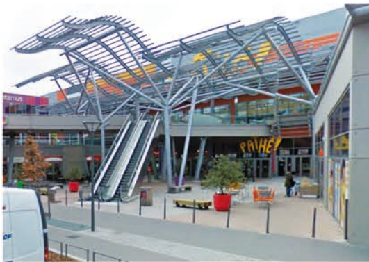
2 : Entrée par la place centrale
