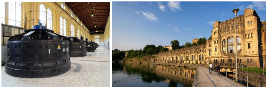
Barrage hydro électrique de Taccani (Lombardie, Trezzo/Adda)
