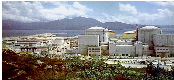
Centrale nucléaire chinoise Daya Bay (1993) 1 er grand transfert technologique sur le secteur Sur la base du transfert français Framatome, Spi et Alstom.
