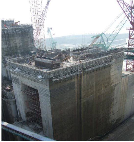
Phase de génie civil en vue de l'installation d'équipements hydroélectriques (Chine)
