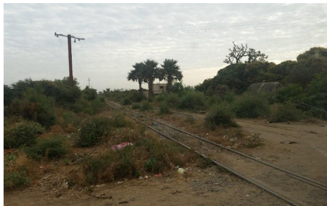
Ligne ferroviaire Dakar-Bamako
