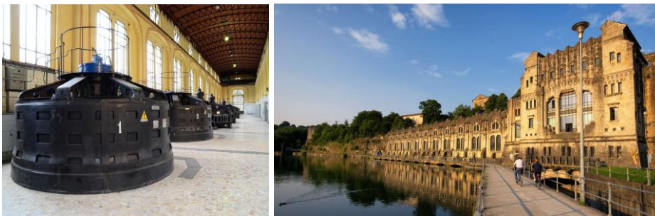
Barrage hydro électrique de Taccani (Lombardie, Trezzo/Adda)
