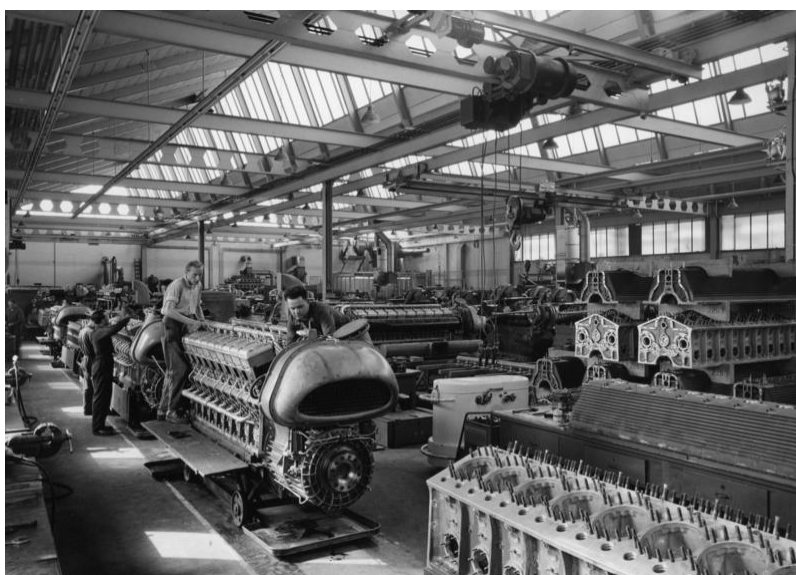
Site historique de Daimler-Benz à Stuttgart (1956). De multiples applications industrielles dans de nombreux secteurs. Nous pourrions prendre de même l'exemple de BMW, Siemens, Alstom, Thyssen, etc.
