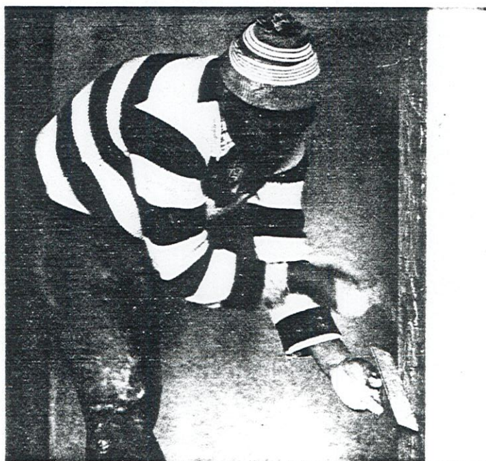
Lissage au Fortas et polissage
