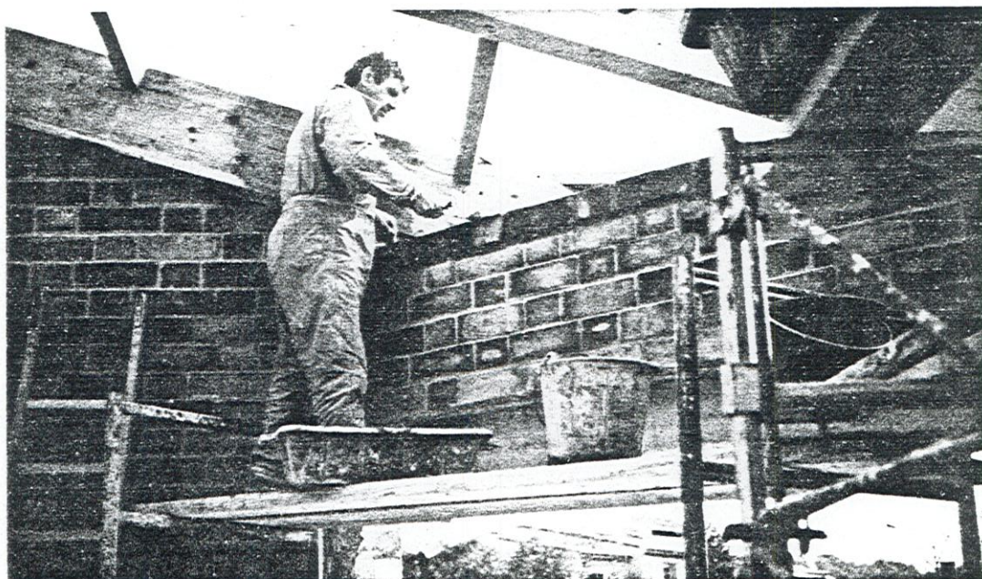
Maison bioclimatique en briques de terre stabilisée
