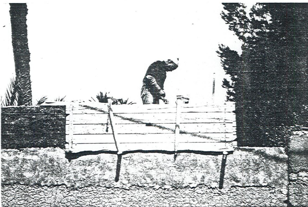
Contrôle de la verticalité du moule au fil à plomb.
