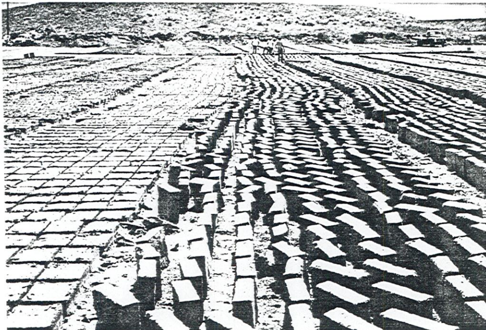
Séchage des briques d'adobe, à plat (1ère phase) et sur le chant (2ème phase)
