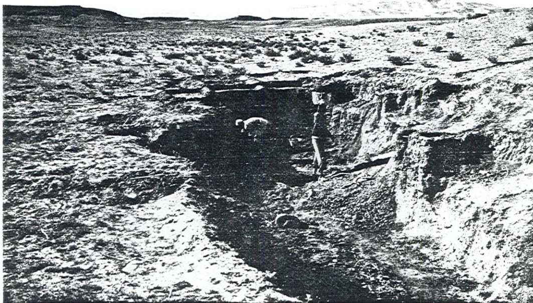
Une carrière de terre à pisé. On remarque l'humidification préalable de la terre ; l'eau est retenue par un système de petits bassins clos par des levées de terre.
