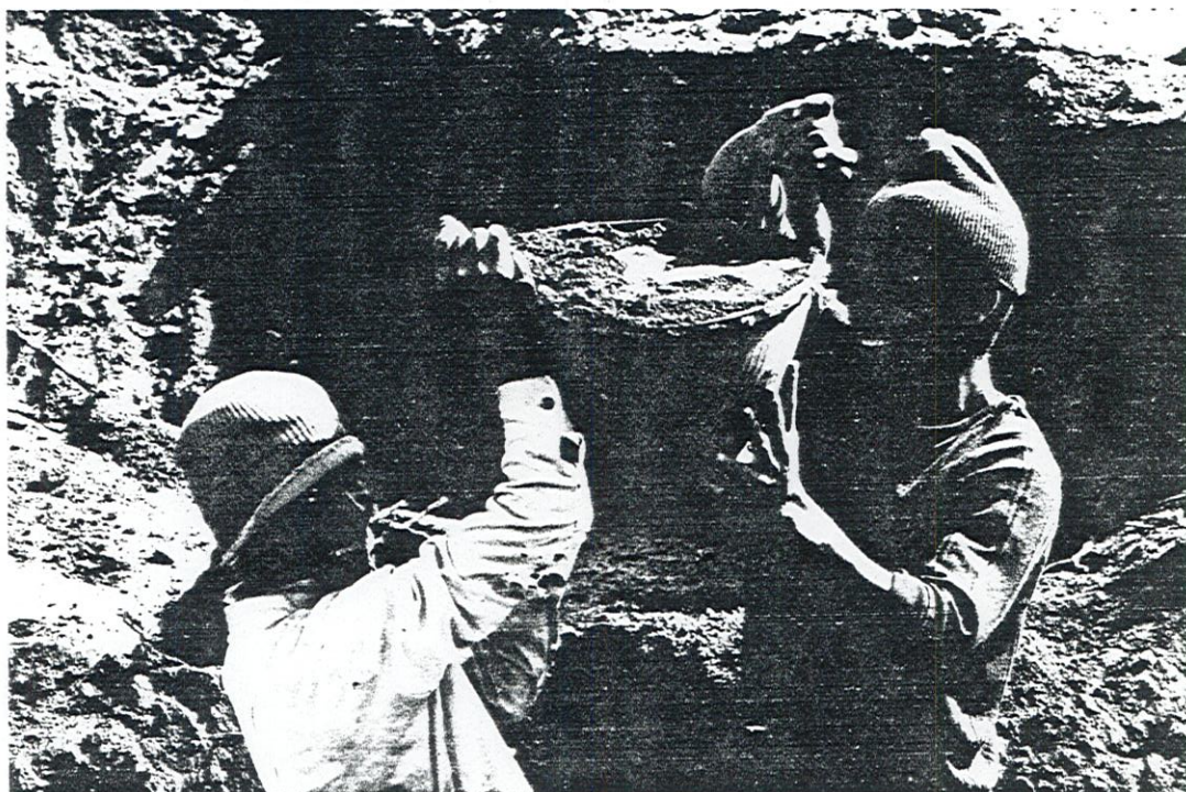
Chargement de la terre dans un couffin prête à être pisée par le maâlem
