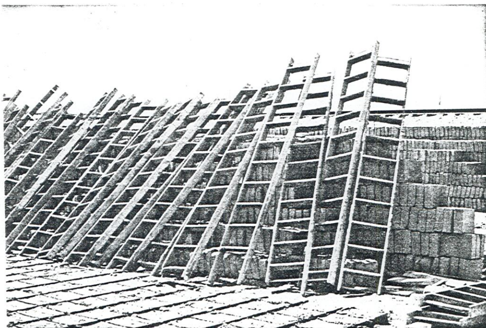
Nettoyage et séchage des moules avant reprise de la production.
