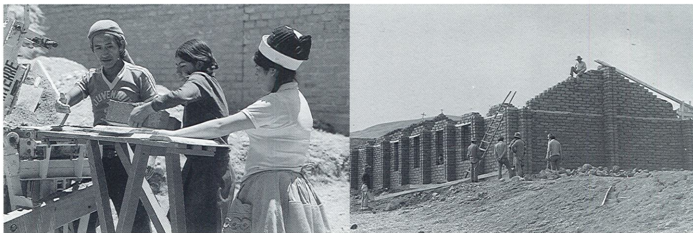
Utilisation d'une presse issue d'une recherche-développement sur les matériels de production, au Pérou. Construction et chantier-formation d'un bâtiment dans un village andin à coût très économique et appliquant des solutions constructives antisismiques.
