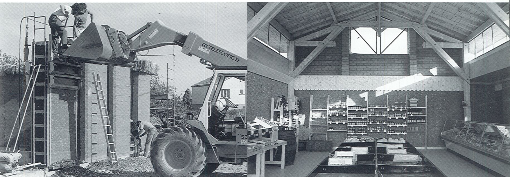
Construction d'une Halle de vente de produits maraîchers et régionaux avec la participation d'un groupe d'agriculteurs, en France. Expérimentation d'une nouvelle branche.
