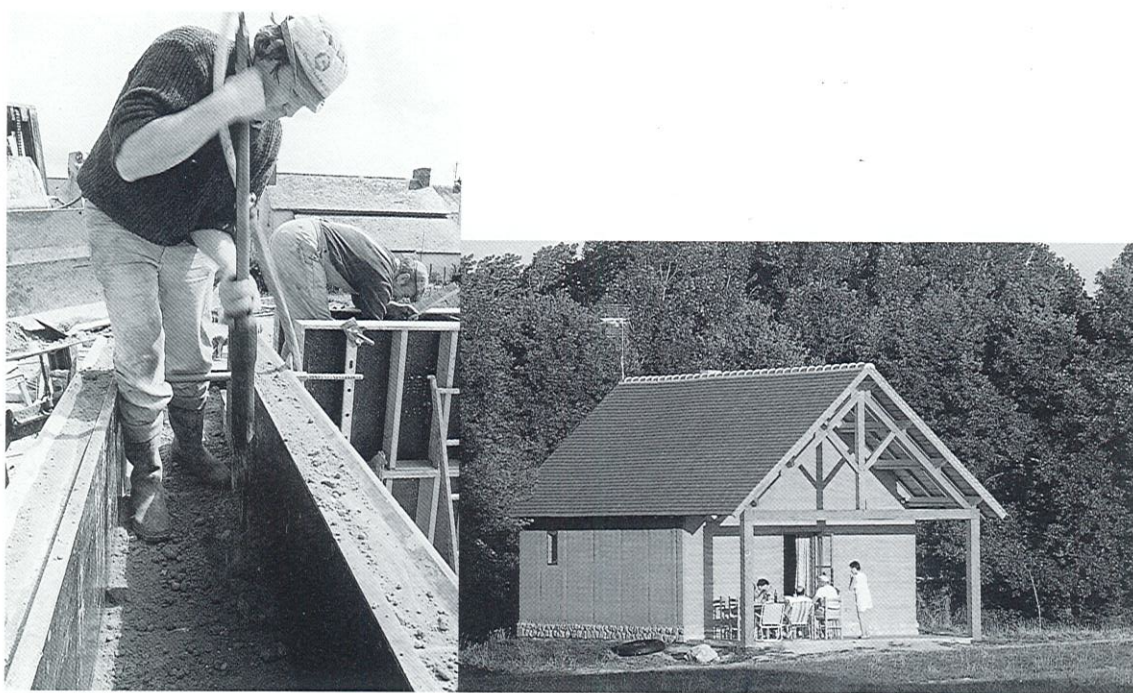
Assistance technique à la réalisation d'un habitat auto-construit, en France. Réactualisation de la technique du pisé.
