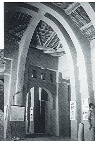
La vitalité des cultures constructives de l'architecture en terre du Nord Nigéria. Un chantier de restauration d'un monument national où sont reconstruits les célèbres arcs en terre armée de bois local (azara). Le savoir-faire est aujourd'hui transmis par de vieux maîtres maçons. La mosquée de Zaria, au Musée d'Architectures Traditionnelles Nigériennes de Jos, qui fut construite en appliquant cette culture constructive des arcs de terre armée.
