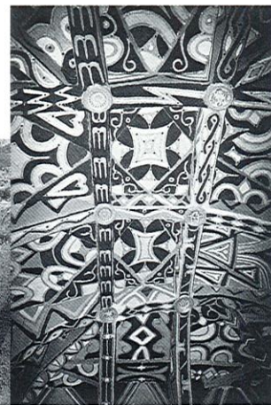
Restauration d'un arc en terre armée de bois d'azara, sur un monument national du Nord Nigéria. Le plafond de la maison de réception de l'émir de Kano où l'on observe une riche décoration peinte avec des pigments naturels mêlés à une poussière de granit qui met en valeur ce principe constructif des arcs en terre armée de bois.
