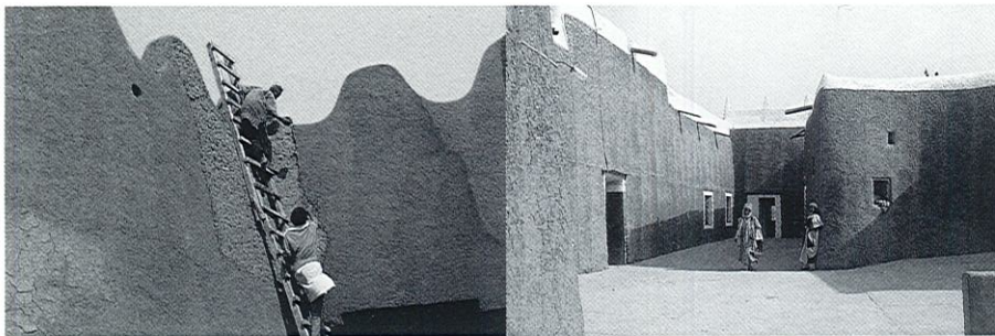
Restauration d'une partie des murailles en terre (briques tubalis empilées) de la célèbre ville de Kano (Etat du Bakwai du Nord Nigéria), reproduite au Musée d'Architectures Traditionnelles Nigériennes de Jos. Le Palais de l'émir de Daura, autre ancienne cité (Etat du Nord Nigéria).
