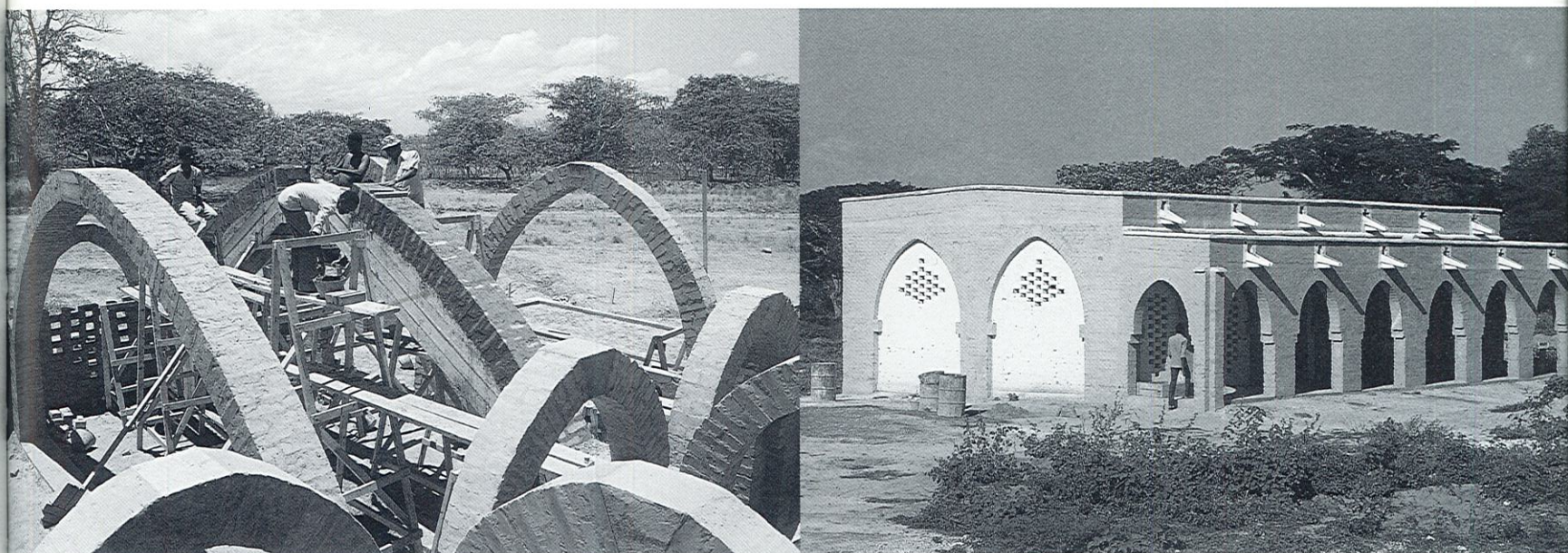
Chantier-production-formation en Somalie avec l'Unité d'architecture pour l'éducation de l'UNESCO. Réalisation d'un ensemble pilote de bâtiments d'écoles en milieu rural avec des solutions constructives de toitures sans bois.
