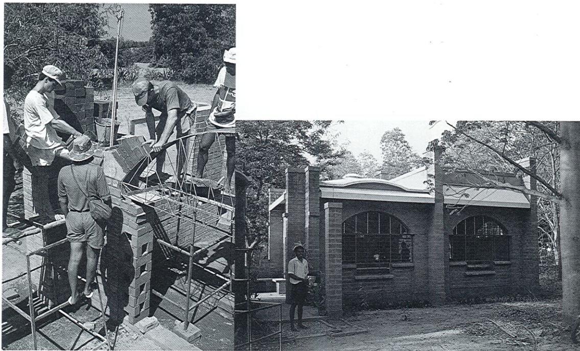
Formation sur chantier, en Inde avec développement de solutions constructives massives en petits éléments. Phase prototype et chantier du Centre d'Information et de Documentation sur les matériaux locaux et les technologies alternatives.
