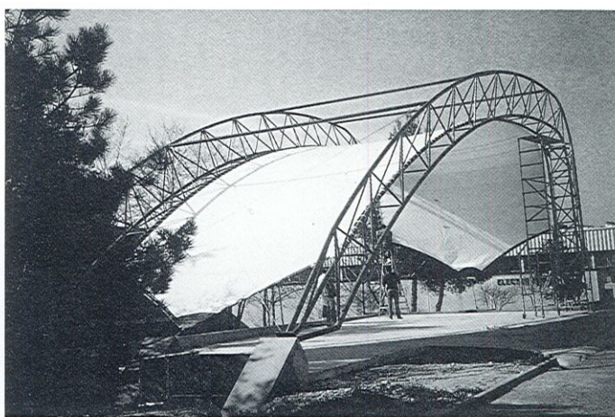
Le GrrSLA a réalisé l'étude complète et assuré la construction d'une structure metallo-textile comportant deux arcs tridimensionnels de 19 mètres de portée recevant une toile prétendue d'une surface de 120 mètres carrés. Cette construction, commandée par l'IUT de Montpellier-Nîmes, a été menée à son terme grâce à la collaboration de nombreux organismes et avec l'aide du groupe Arcora.
