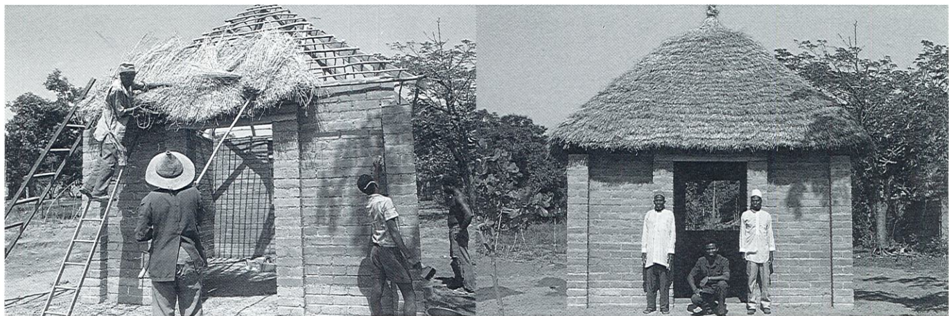
Petit bâtiment de démonstration réalisé à Jos, Nigéria, dans le cadre d'un séminaire national de formation sur l'habitat économique.
