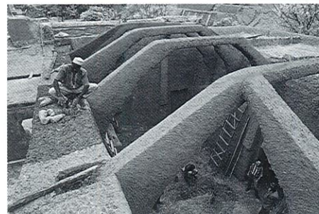
La vitalité des cultures constructives de l'architecture en terre du Nord Nigéria. Un chantier de restauration d'un monument national où sont reconstruits les célèbres arcs en terre armée de bois local (azara). Le savoir-faire est aujourd'hui transmis par de vieux maîtres maçons. La mosquée de Zaria, au Musée d'Architectures Traditionnelles Nigériennes de Jos, qui fut construite en appliquant cette culture constructive des arcs de terre armée.
