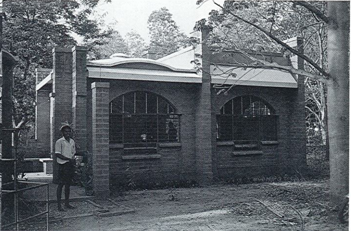
Formation sur chantier, en Inde avec développement de solutions constructives massives en petits éléments. Phase prototype et chantier du Centre d'Information et de Documentation sur les matériaux locaux et les technologies alternatives.
