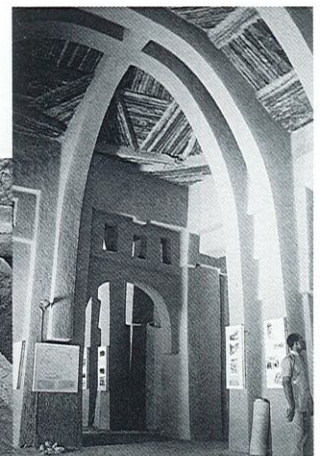
La vitalité des cultures constructives de l'architecture en terre du Nord Nigéria. Un chantier de restauration d'un monument national où sont reconstruits les célèbres arcs en terre armée de bois local (azara). Le savoir-faire est aujourd'hui transmis par de vieux maîtres maçons. La mosquée de Zaria, au Musée d'Architectures Traditionnelles Nigériennes de Jos, qui fut construite en appliquant cette culture constructive des arcs de terre armée.
