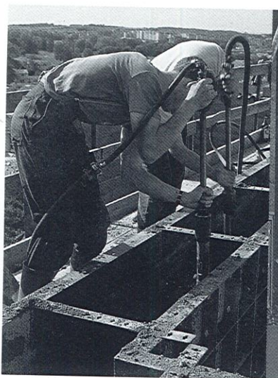
Réactualisation de la technique de construction en pisé sur un des projets de logements du "Domaine de la Terre de l'Isle d'Abeau". Solutions de coffrage intégral avec damage pneumatique.
