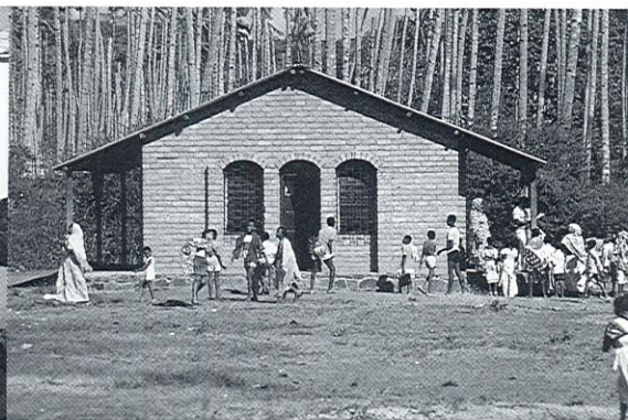
Ecoles primaires à Mayotte. Des murs pignons épais et deux arcatures pour des varangues latérales donnant de l'ombrage et une ventilation naturelle transversale.
