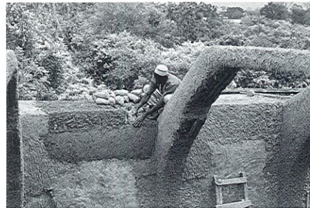
Restauration d'un arc en terre armée de bois d'azara, sur un monument national du Nord Nigéria. Le plafond de la maison de réception de l'émir de Kano où l'on observe une riche décoration peinte avec des pigments naturels mêlés à une poussière de granit qui met en valeur ce principe constructif des arcs en terre armée de bois.
