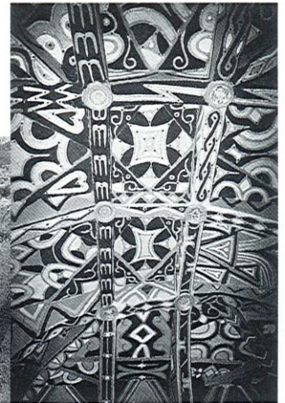
Restauration d'un arc en terre armée de bois d'azara, sur un monument national du Nord Nigéria. Le plafond de la maison de réception de l'émir de Kano où l'on observe une riche décoration peinte avec des pigments naturels mêlés à une poussière de granit qui met en valeur ce principe constructif des arcs en terre armée de bois.
