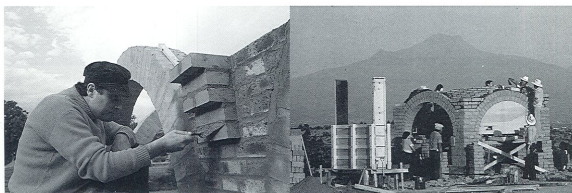
Cours national de construction en terre, au Mexique, organisé à la demande de la CONESCAL, pour la réalisation d'équipements éducatifs. Réactualisation de l'architecture en arcs, voûtes et coupoles.
