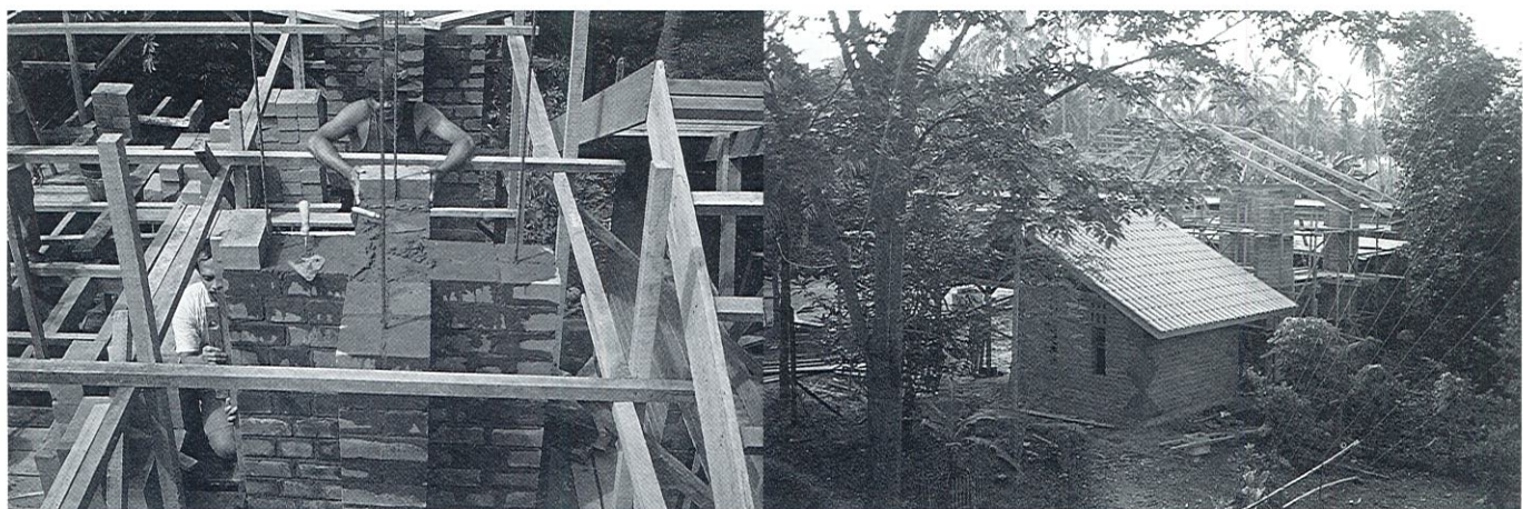
Construction d'un prototype d'habitat mettant en application des solutions constructives antisismiques, aux Philippines. Chantier réalisé par des professionnels, architectes et entrepreneurs en stage de formation.
