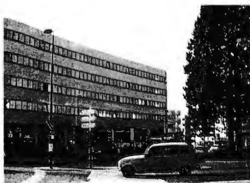
3 • vue à partir du rond-point - bât. adm. (107)
