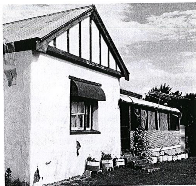
Fig. 20 : Maison en pisé construite dans les années 30, Australie, Jugiong, New South Wales.
