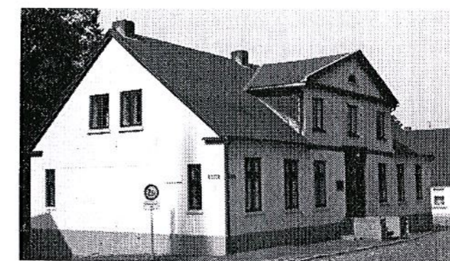
Fig. 26 : Vue de la Maison Boeckmann, à Meldorf, Schleswig-Holstein, Allemagne. In revue "Bauen mit Lehm" n° 2, p. 5, op. cit. en note de texte 56.
