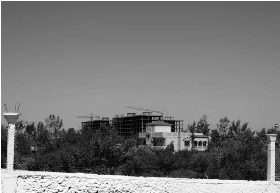
Fig. 4: Exemple de concurrence entre agriculteurs et promoteurs dans la zone du POS 25 (juin 2010). En avant-plan: clôture récente de l'exploitation agricole et occupation nouvelle par de l'arboriculture. En arrière-plan: construction pavillonnaire au milieu des cultures. Logements collectifs en cours sur une exploitation agricole limitrophe. Source: cliché Ghodbani et Messabel.
